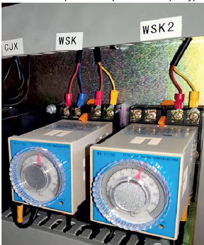
Малюнок 37 - реле контролю температури
