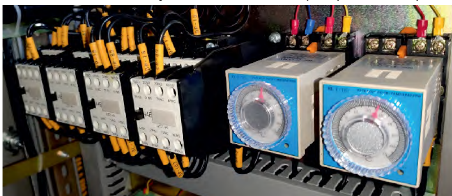
Малюнок 4.5 - комутаційні контактори і реле контролю температури
