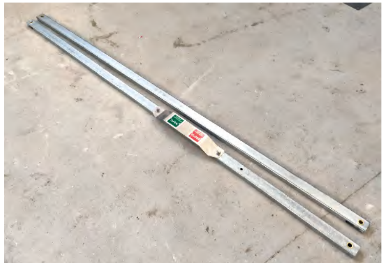
Малюнок 13 - загальні тяги полюсів вимикача
