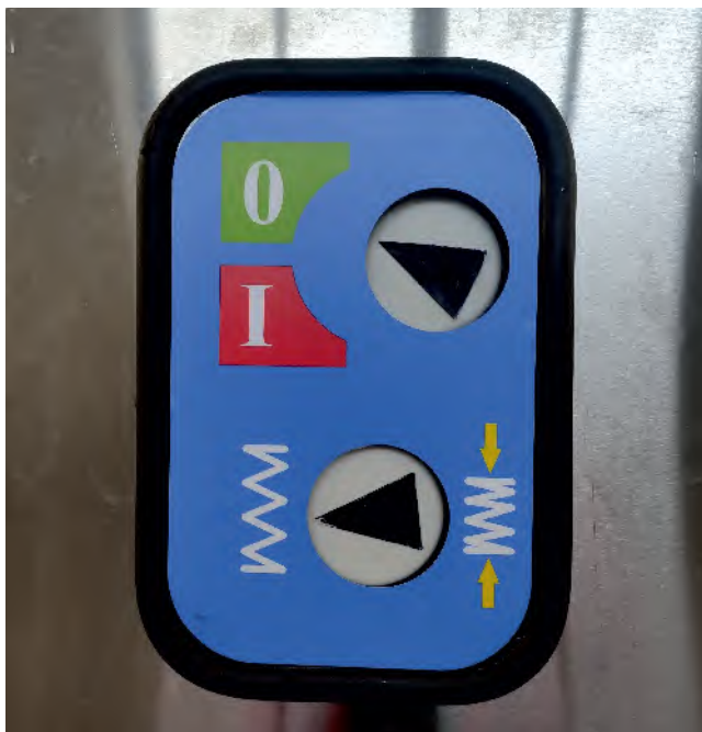
Малюнок 7 - індикатори стану вимикача та пружини включення
