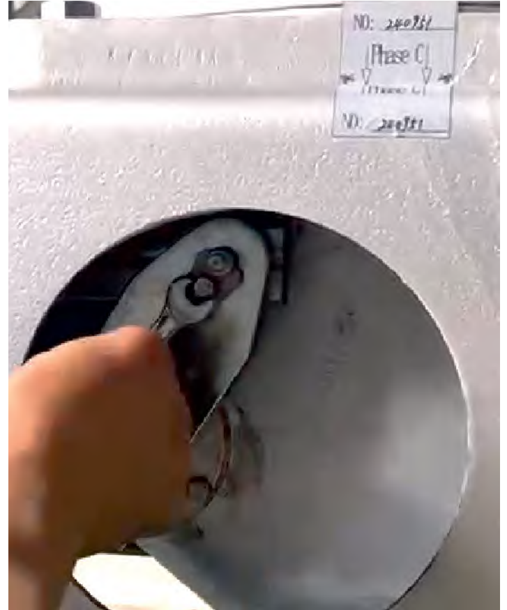
Малюнок 25 - з'єднувальна вісь тяги та механізму в робочому положенні
